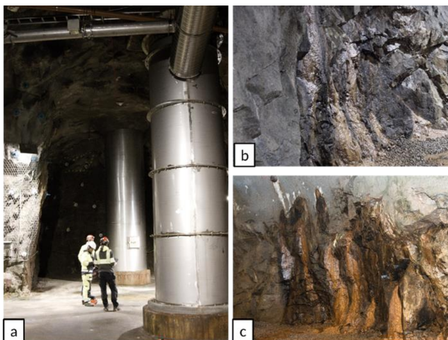
Figur 11. Två av de inspekterade platserna a) hissområde med ventilationsschakt b) plats NASA 0748 med vatteninträngning vid bergväggen c) plats NASA 0748 med vatteninträngning vid ett annat ställe.
