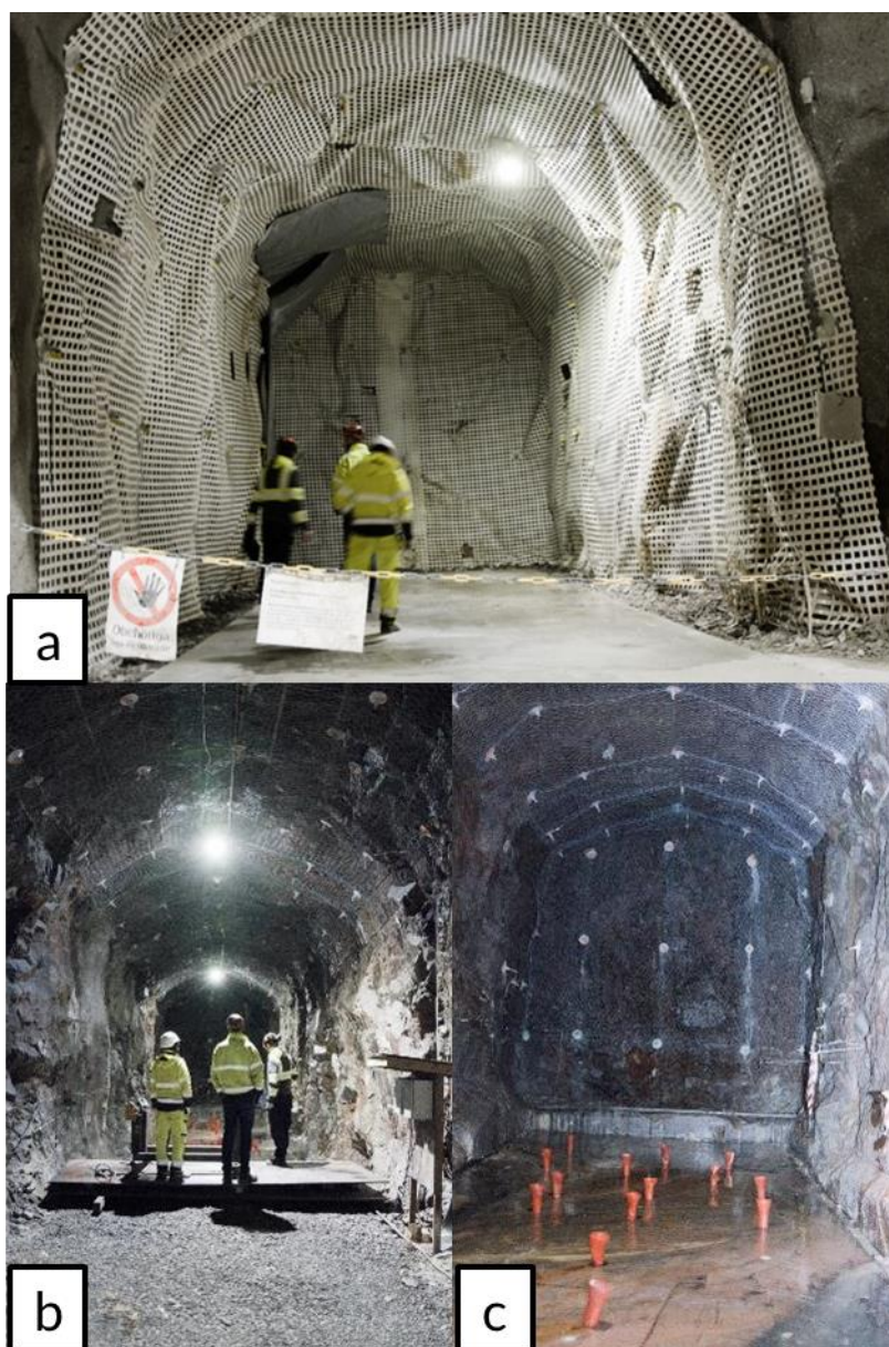
Figur 10. De besiktigade platserna runt ~400 m: a) plats TAS05 b) plats TAS 04 generell överblick c) plats TAS 04 som visar vatteninträngning på tunnelgolvet.
